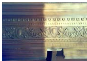
RIPRISTINO PORTE, FINESTRE E MOBILI
